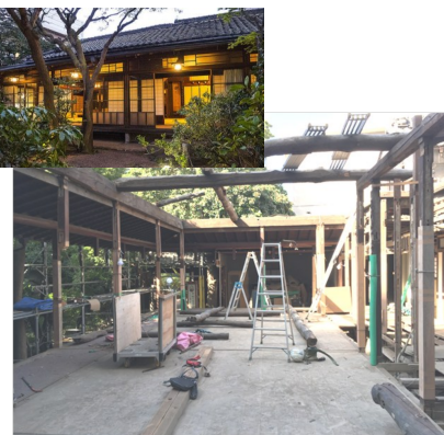
R4.10 鷗外荘解体工事
