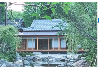
R7.07 建物工事完了
