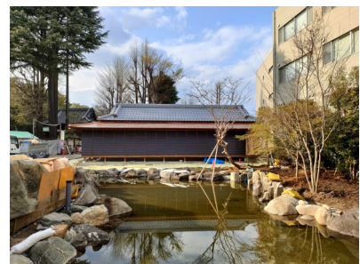
R7.03 屋根葺き完了
