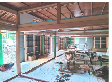
R7.05 内装工事
