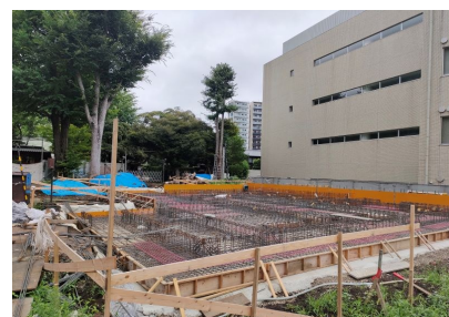
R6.07 建物基礎工事
